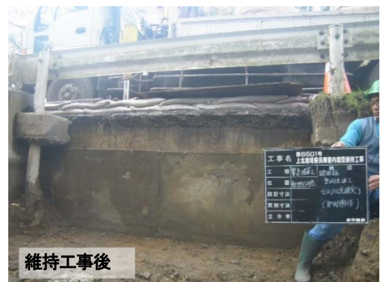
写真-6 維持工事の実施状況
