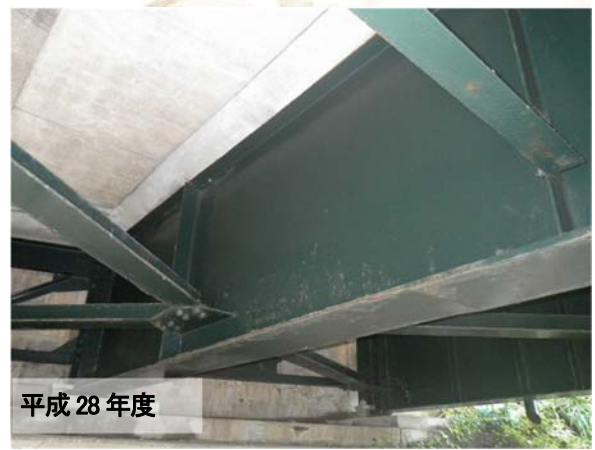
写真-2 健全度回復後の維持状況（鋼主桁）
