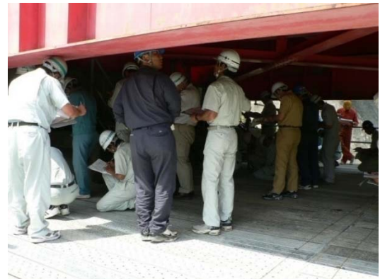
写真-4 橋梁点検技術研修
