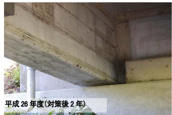
写真-3 健全度回復後の維持状況（コンクリート主桁）
