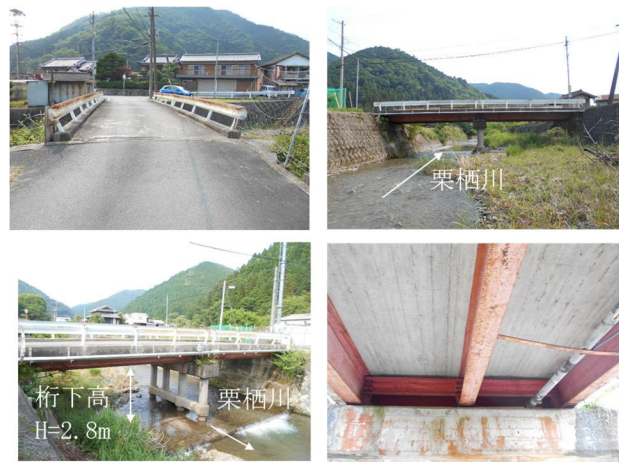
写真-2 大荒田橋
