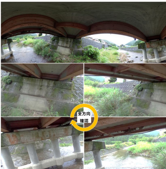
写真-4 桁下部で撮影した 360 度カメラ画像(大荒田橋)
