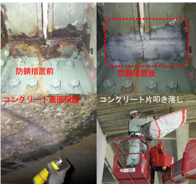
図-5.6 点検時応急措置（鋼桁端部の防錆措置）
