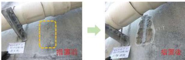
(a) ①Co 片叩き落とし+②露出鉄筋の防錆+③Co 表面防護
